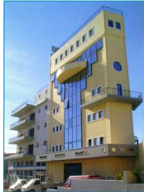
Η πίσω όψη του νέου κτιρίου
