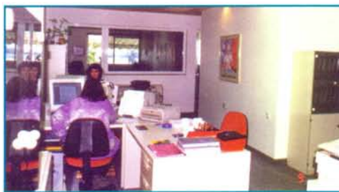
Άποψη από την ανακαίνιση των γραφείων στο παλιό κτίριο της εταιρίας
